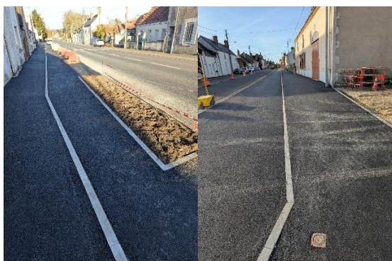
Création d'une piste cyclable à Lailly-en-Val Subvention CRST : 51 300 €
