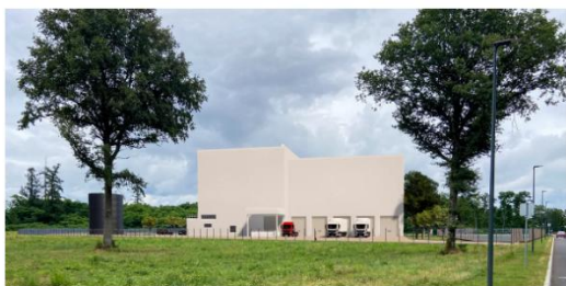
L'esquisse de la chaufferie une fois finie (Engie Solutions).
