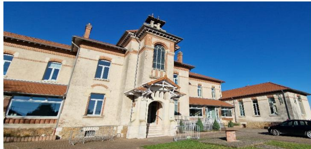
Isolation du centre de loisirs à Meung-sur-Loire Coût (isolation) : 520 000 € HT - Subvention CRST : 260 200 €
