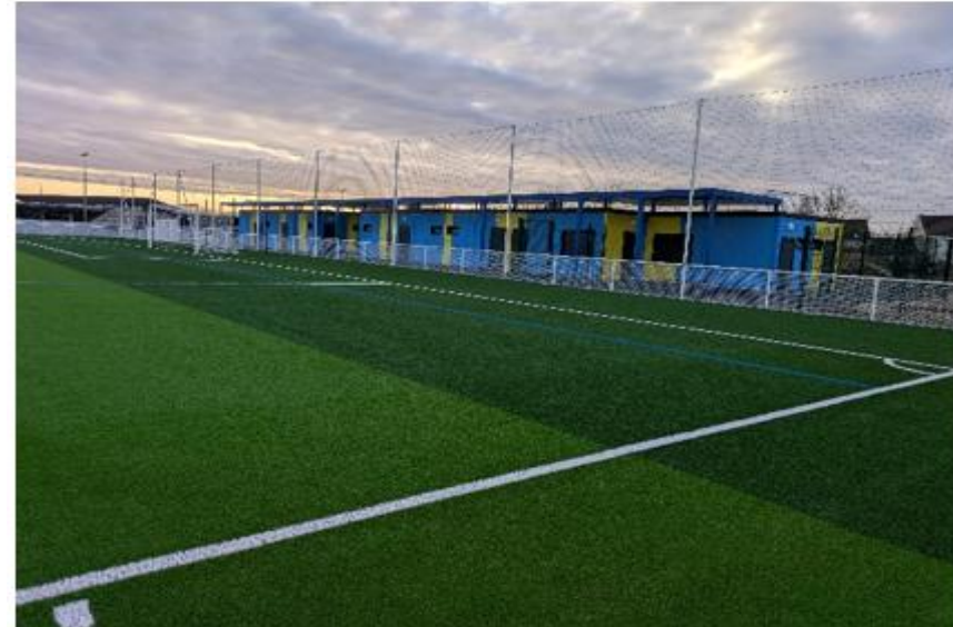
Création d'un nouveau stade à Beaugency Subvention CRST : 396 700 €
