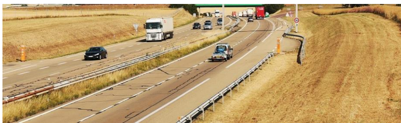
Tronçon de l'A19 reliant Artenay à Sens
