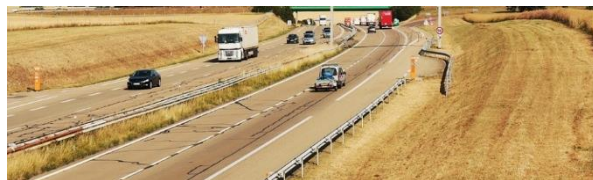
Tronçon de l'A19 reliant Artenay à Sens
