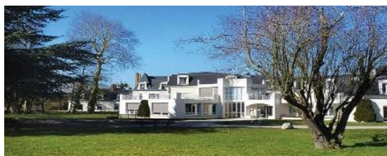
Maison de retraite à Meung-sur-Loire
