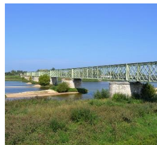
Image 30: Viaduc ferroviaire de Sully-sur-Loire
