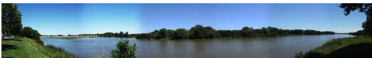
Image 10: Vue sur le pont de Beaugency.
