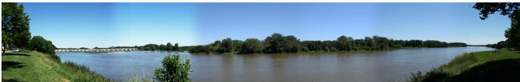
n°75 – vue sur le pont de Beaugency
