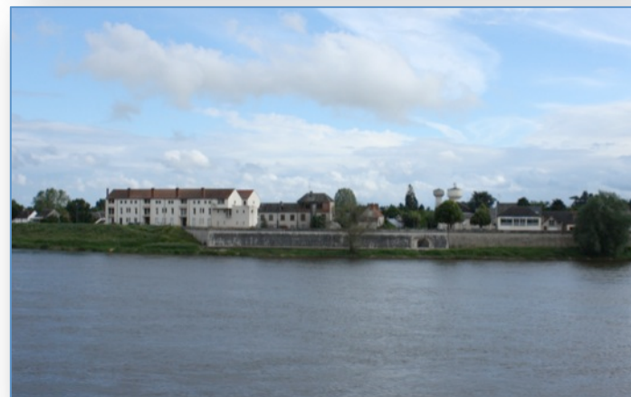
Exemples de bâtiments disproportionnés sur les rives de Loire
