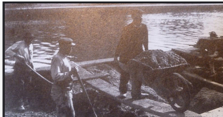
Le déchargement du sable à la brouette
