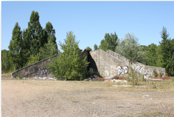
Équipement lié à l'extraction de sable à l'abandon
