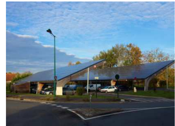
Aire de covoiturage de la ZAC de Faye-Aux-Loges équipé de panneaux photovoltaïques (électricité créée alimente toute la ZAC)
