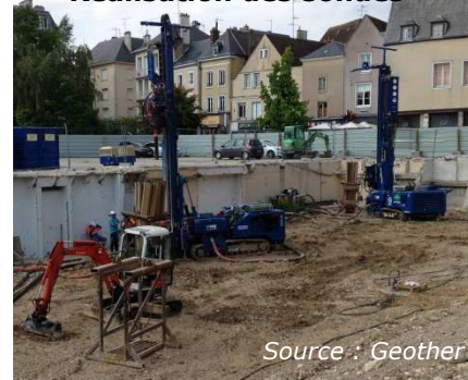
Réalisation des sondes
