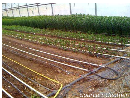
Émetteurs au niveau du sol
