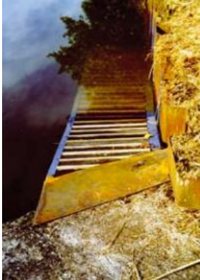
Figure 1 : Echelle à gibier (source : VNF / E. Paris)
