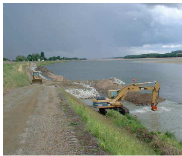
Figure 23 : Rives de la Loire (Source : Charte architecturale et paysagère du Pays Loire Beauce)
