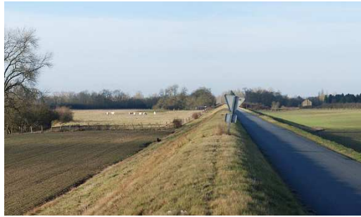
Figure 27 : Levée séparant des pâturages et des terres de grande culture
